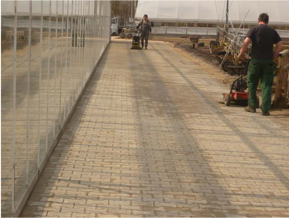
3) Pflasterungen werden mit dem „Rüttler“ gefestigt
